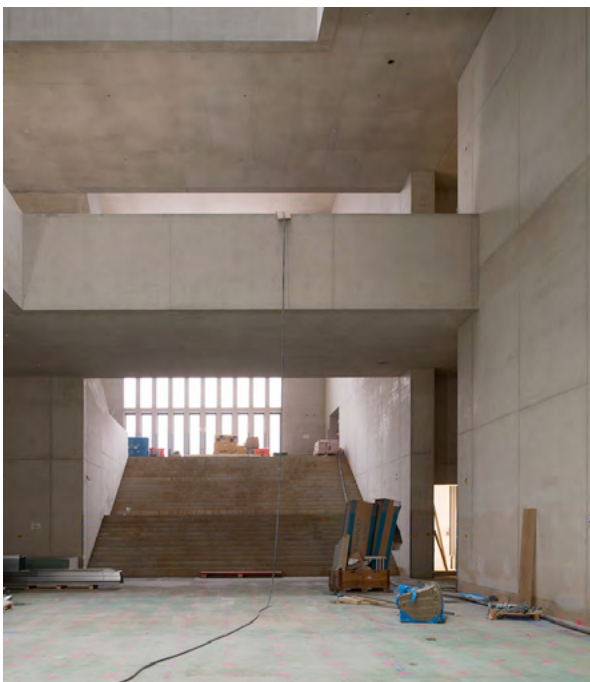
Béton recyclé dans le nouveau bâtiment du Kunstmuseum à Zürich
